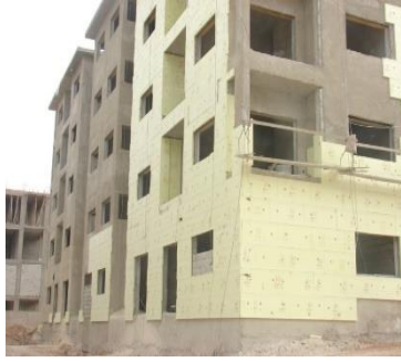
(الشكل 5): المبنى (أ) تطبيق طبقة عازلة على كامل مغلف البناء
